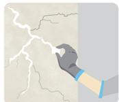
**MENGISI RETAK TEMBOK**, Untuk mengisi retak tembok berukuran kurang dari 1mm, Anda dapat menggunakan Asian Paints TruCare Alkali Wall Putty.
